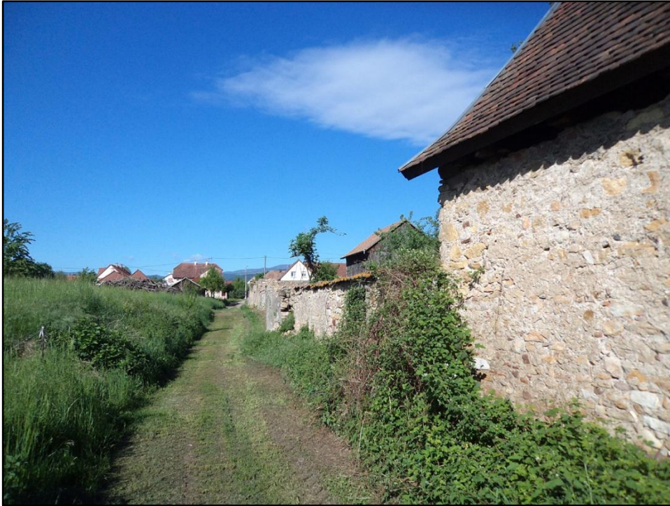
Murs clôtures et granges délimitent le village ancien au Sud
